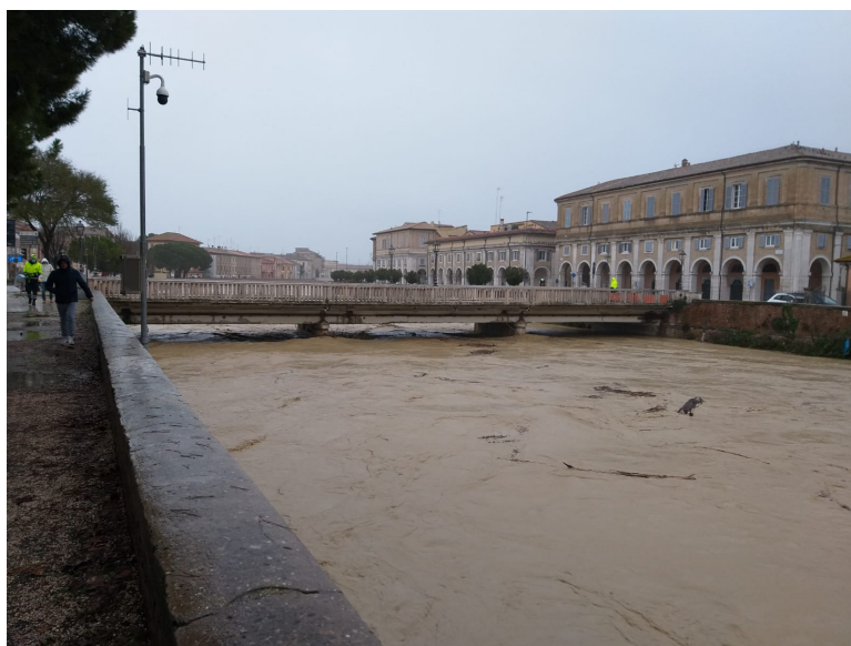
Figura 37: Fiume Misa all'altezza di Ponte Garibaldi a Senigallia)
